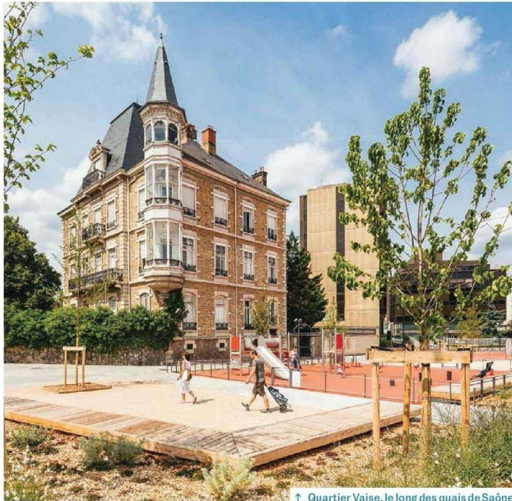
↑ Quartier Vaise, le long des quais de Saône.
